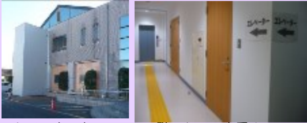
エレベータのタワー 1階エレベータ乗り口
